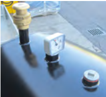
Indicador de nivel visual y filtro de carbones activos. Indicador de nivel visual e filtro de carvão ativado.
